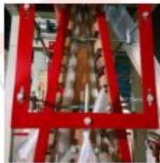
Gambar 7. Collapsing frame Sumber: PT Pangestu Jaya Makmur, 2023
